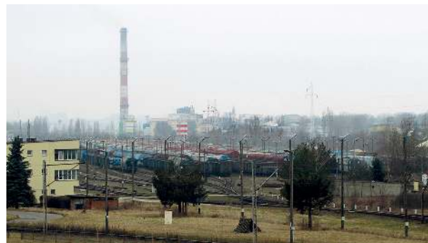
Il. 1. Widok panoramiczny z wiaduktu przy ul. Grygowej w kierunku opracowywanego terenu
