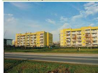
Widok na osiedle od strony północnej
